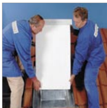
13.2 A kéményfejet függőlegesen felhelyezzük.
