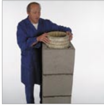
6.2 A szigetelő lapot meghajlítjuk és behelyezzük.
