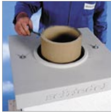
11.10-11.11-11.12 A samottcsőre helyezük fel a kúpot és a Schiedel tömítő pasztával gondosan tömítsük. Ezzel a kúpot a csőhöz ragasztjuk.
