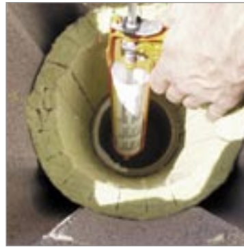
9.3 Hézagkittet hordunk fel a kéménytalpban található cső végére.
