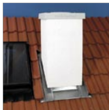
13.3 Az oldalsó csavarokat a köpenytégláig meghúzzuk. A torkolati kúpot felhelyezzük (ld.: 11.1-11.12 ábrák)
