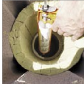
6.3 A samottcső felső, külső korcolású felületére hézagkittet nyomunk. A következő samottcső mindkét végét nedvesítjük.
