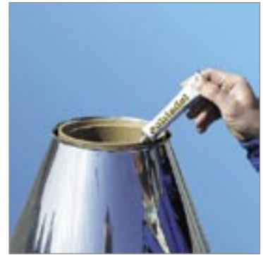
11.10-11.11-11.12 A samottcsőre helyezük fel a kúpot és a Schiedel tömítő pasztával gondosan tömítsük. Ezzel a kúpot a csőhöz ragasztjuk.
