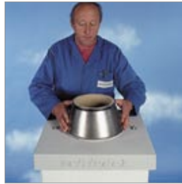
11.10-11.11-11.12 A samottcsőre helyezük fel a kúpot és a Schiedel tömítő pasztával gondosan tömítsük. Ezzel a kúpot a csőhöz ragasztjuk.
