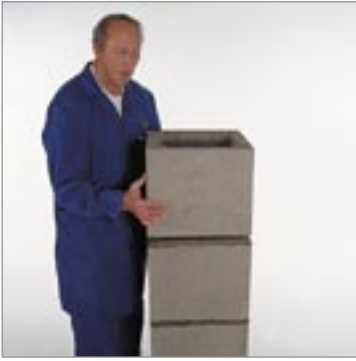
6.1 A köpenytéglát a habarcs-terítésbe helyezzük
