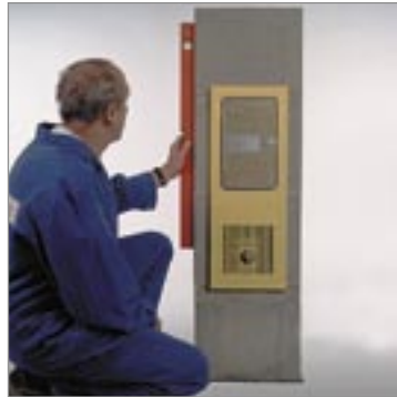
7.2 A kéménytalpat függőlegesen a habarcsba állítjuk.
