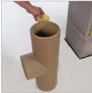
9.2 Megtisztítjuk és benedvesítjük a füstcső-csatlakozó csővégeit.
